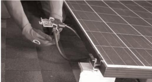
9. Befestigen Sie die Kabelklemme an der Unterseite des Modulrahmens.
