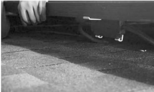
10. Befestigen Sie das Engage-Kabel bei Bedarf mit Kabelbindern am Modulrahmen.
