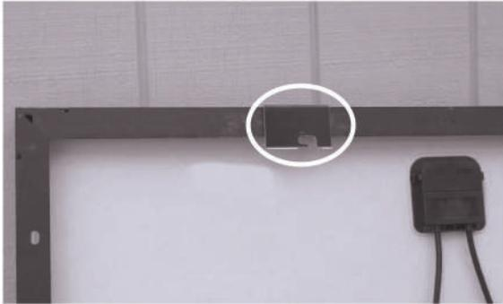
2. Drehen Sie die Schraube in die Öffnung an der Halterung und schieben Sie dann den mittleren Kanal des Mikro-Wechselrichters über die Schraube.
