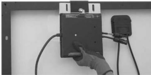
4. Ziehen Sie die Schraube mit einem Steckschlüssel fest (bis zu einem Drehmoment von 18 Nm).
