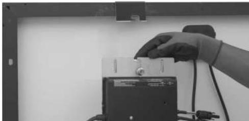
3. Schieben Sie den Mikro-Wechselrichter auf die Halterungsklemme und bewegen Sie ihn dann leicht nach links. Die Schraube hält nun die Rahmenhalterung an der Halterungsklemme. Der Montageflansch des Mikro-Wechselrichters sollte sich an der Außenseite des Modulrahmens befinden.
