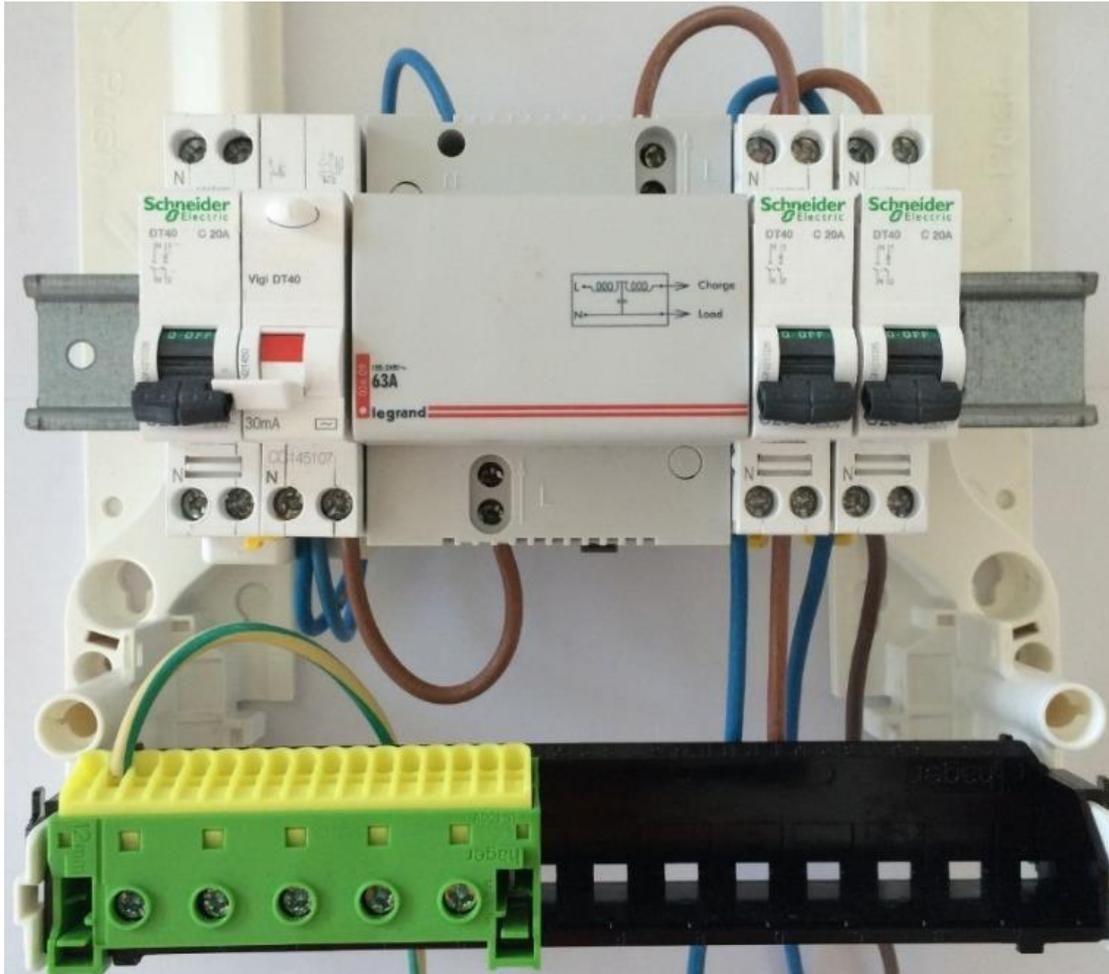
Abb. 9: Legrand-Filter an einer einphasigen Hauptverteilerstation/Lastverteilung
