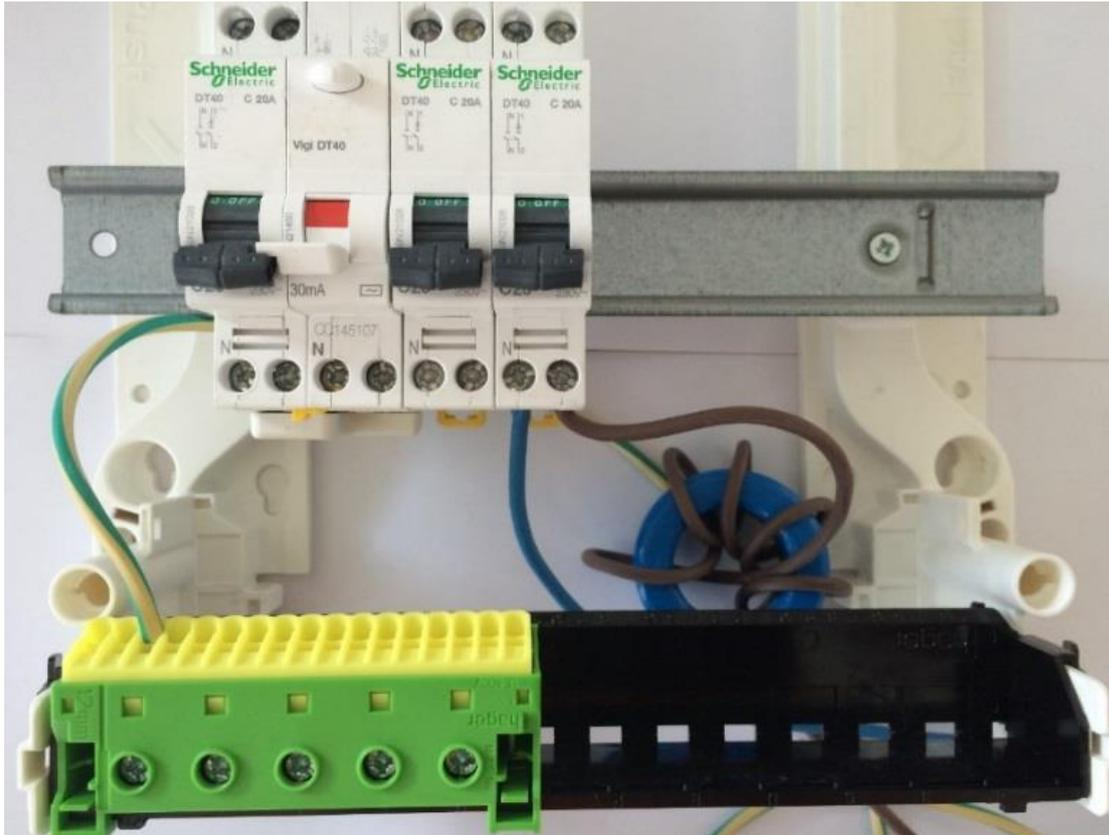
Abb. 8: Ringkerne an einer einphasigen Hauptverteilerstation/Lastverteilung
